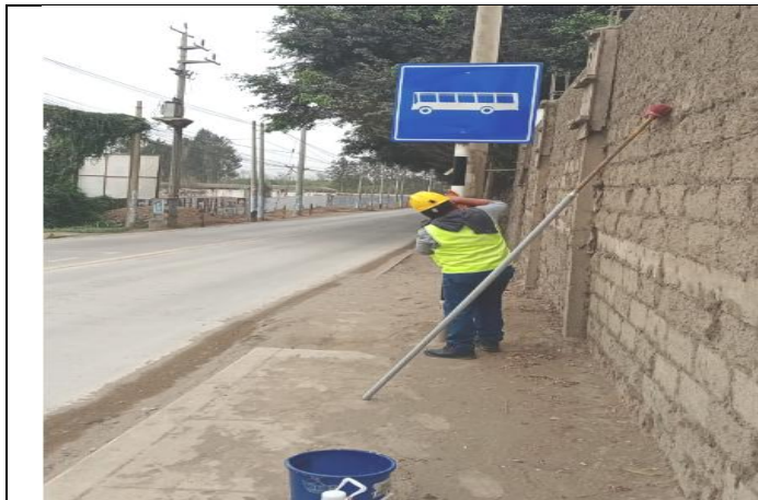
Limpieza y mantenimiento de señales verticales en Av. Manuel Valle.
