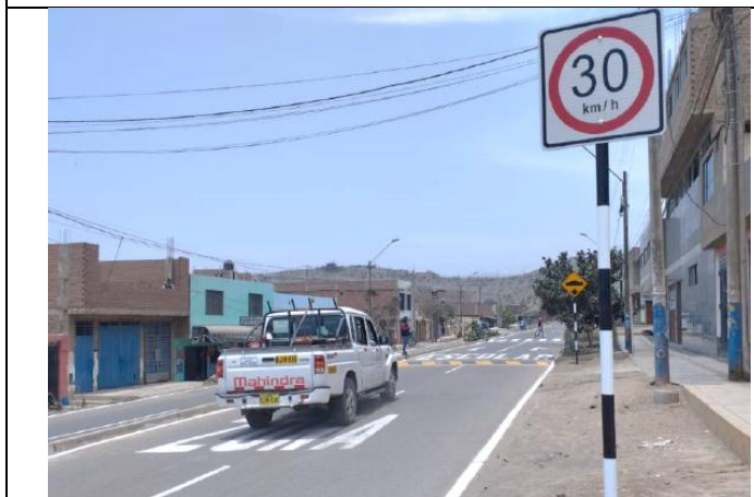
Instalación de señalización vertical en el colegio santísima virgen divina pastora
