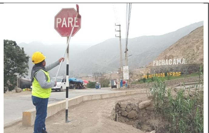
Limpieza y mantenimiento de señales verticales en Av. Manuel Valle Alt. Quebrada Verde
