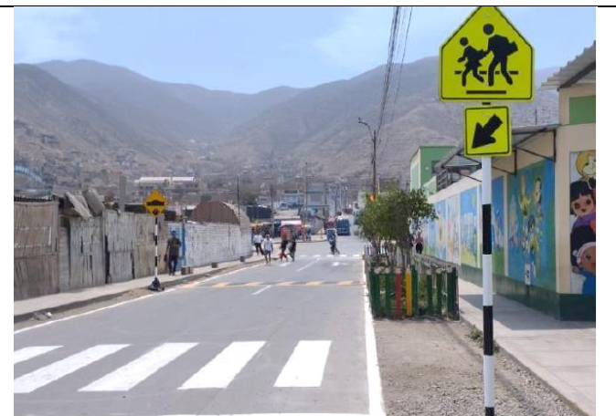
Instalación de señalización vertical en el colegio 668 Roxanita Castro Witting
