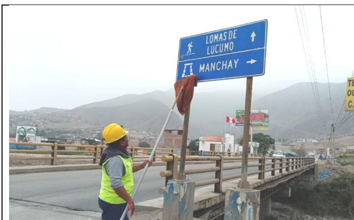
Limpieza y mantenimiento de señales verticales en Puente del río Lurín.
