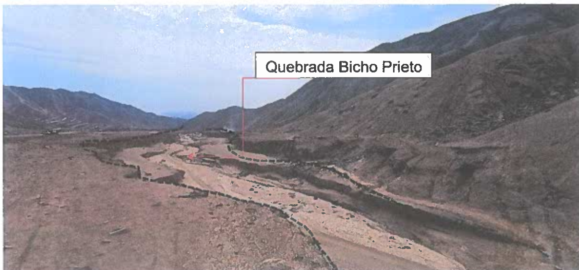
IMAGEN N°1: Cauce principal de la quebrada Bicho Prieto en el sector de los predios del proyecto (vista aguas abajo).
